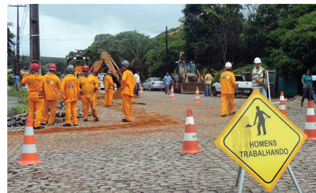
Previsão é que essa parte da obra seja realizada até o dia 08 de abril
